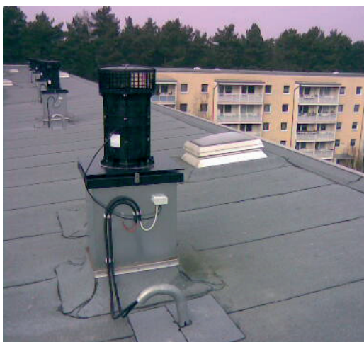
Der Niederdruckventilator DVNDS 315 wird auf dem Schachtkopf mittels eines individuell angepassten Dachklappsockels eingesetzt.
