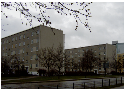
In diesen Mehrfamilienhäusern wurden 110 Wohneinheiten mit der Hybridlüftung ausgestattet.
