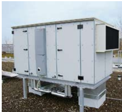
Zehnder ComfoAir 1500 Lüftungsgerät auf dem Dach
