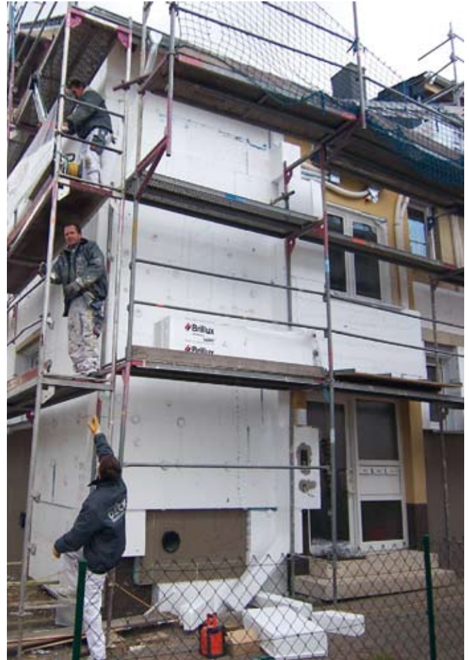
Dämmung während der Bauphase
