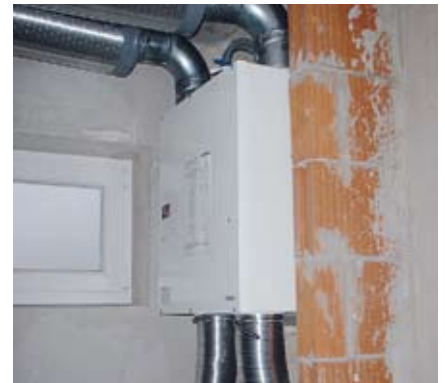
Zehnder ComfoAir 140 Rohbausituation
