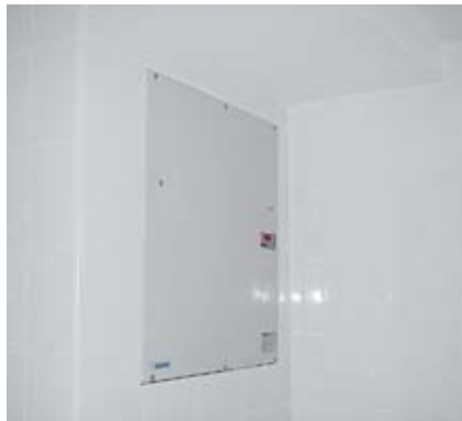
Zehnder ComfoAir 140 im Bad. Integriert in Trockenbauwand
