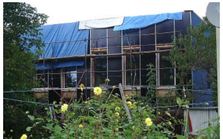
Kollektorfassade im Bau (Stand 4. 10. 2002)
