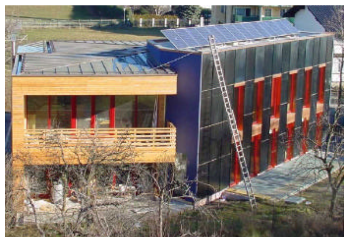
Kollektorfassade im Bau (Stand 4. 10. 2002)
