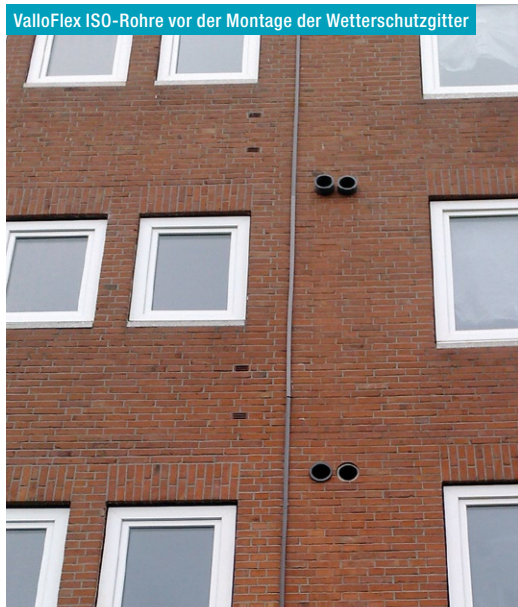
ValloFlex ISO-Rohre vor der Montage der Wetterschutzgitter
