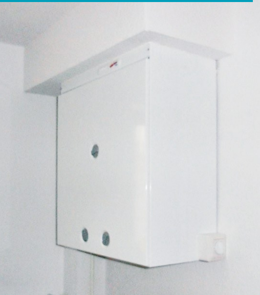
Vallox Lüftungsgerät mit Wärmerückgewinnung im Abstellraum
