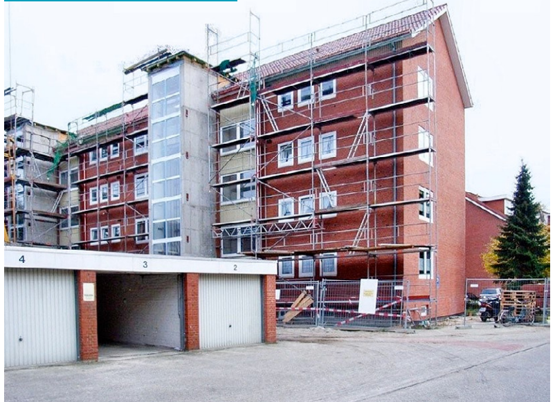
Momentaufnahme während der Sanierung
